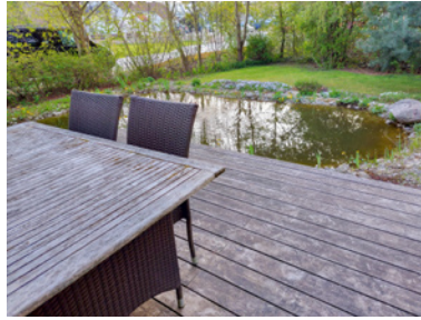
Die Sonnenstrahlen verbrennen die offenporige Oberfläche des unbehandelten Holzes regelrecht, es wird spröde. (Bild: Natural-Farben)
